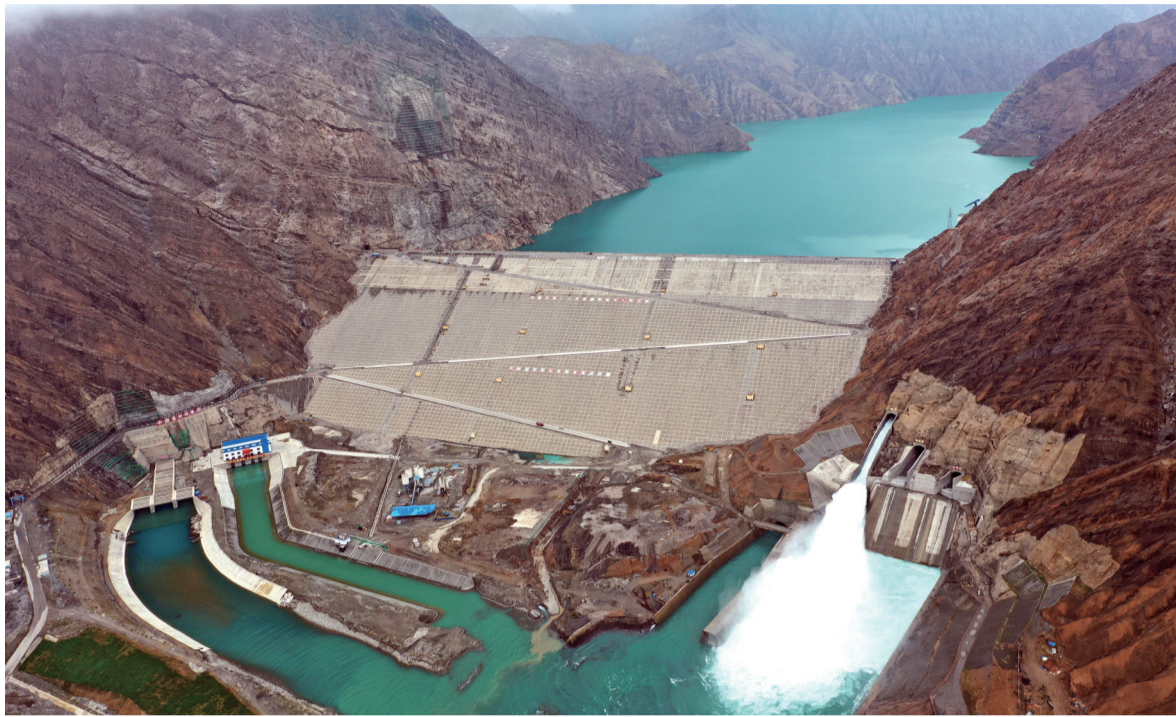
新疆阿尔塔什水利枢纽工程
